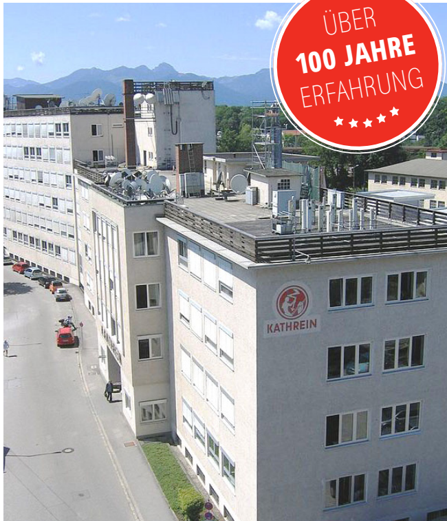
Hauptsitz der KATHREIN Digital Systems GmbH im Zentrum von Rosenheim
